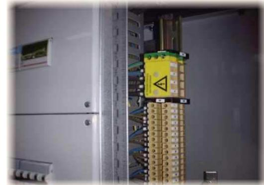
Per convenzione, il neutro usato come conduttore di protezione (PEN) non è parte attiva
